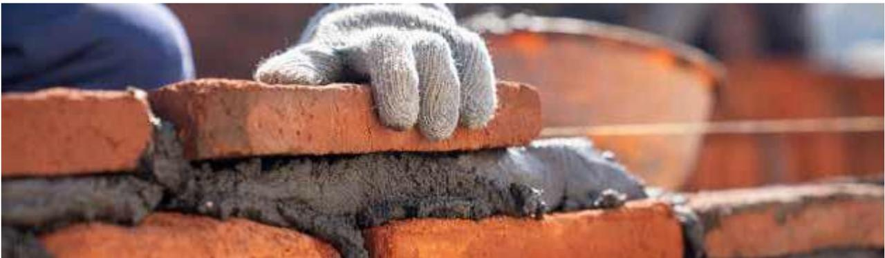
Los morteros de albañilería se definen como una "mezcla compuesta de uno o varios conglomerantes inorgánicos, de áridos, de agua, y a veces, de adiciones y/o aditivos para fábricas de albañilería, rejuntado y trabazón de albañilería". Es esencial que estas mezclas sean homogéneas y que sus componentes se utilicen en proporciones específicas, adaptadas a la aplicación prevista del mortero.
